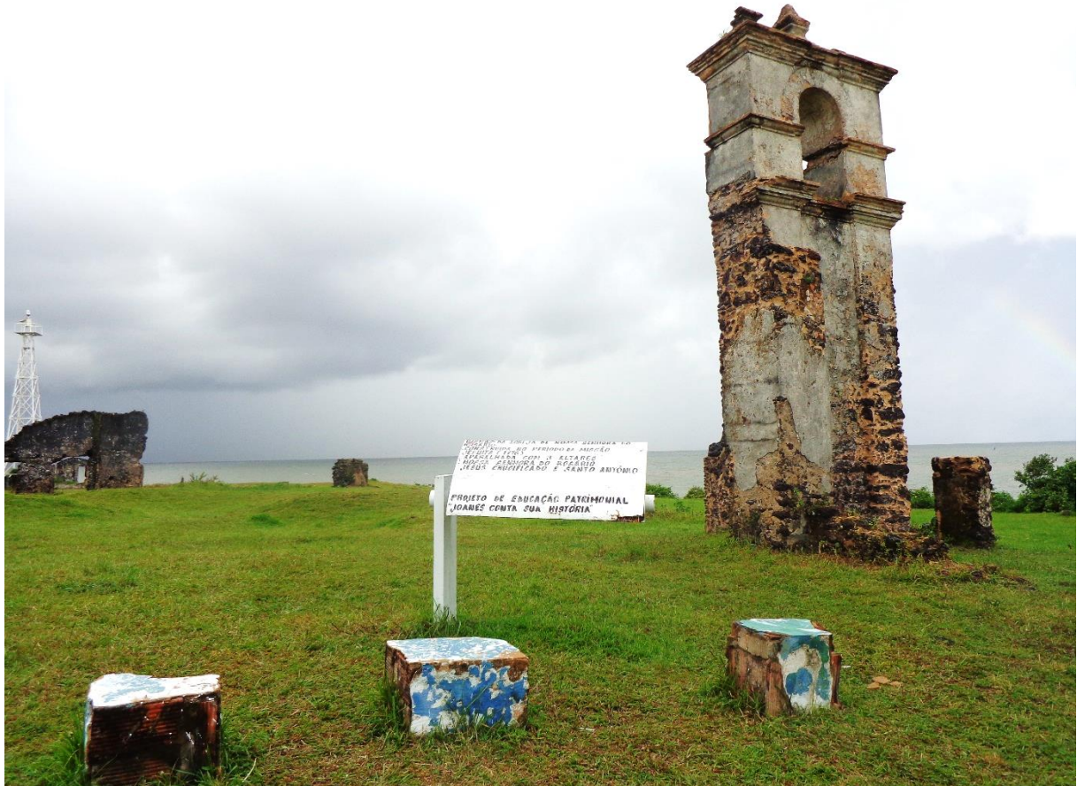
Figura 20 – Ruínas restauradas e os blocos de concreto do coreto. Fonte: Maíra Airoza, 2015.
