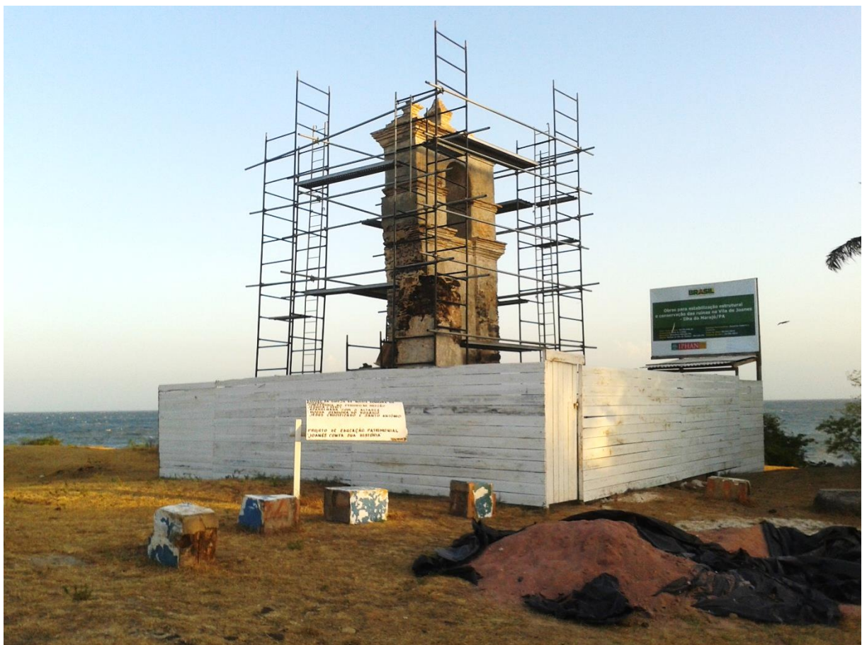
Figura 8 - Torre das ruínas durante o restauro. Foto: Maíra Airoza, 2014.
